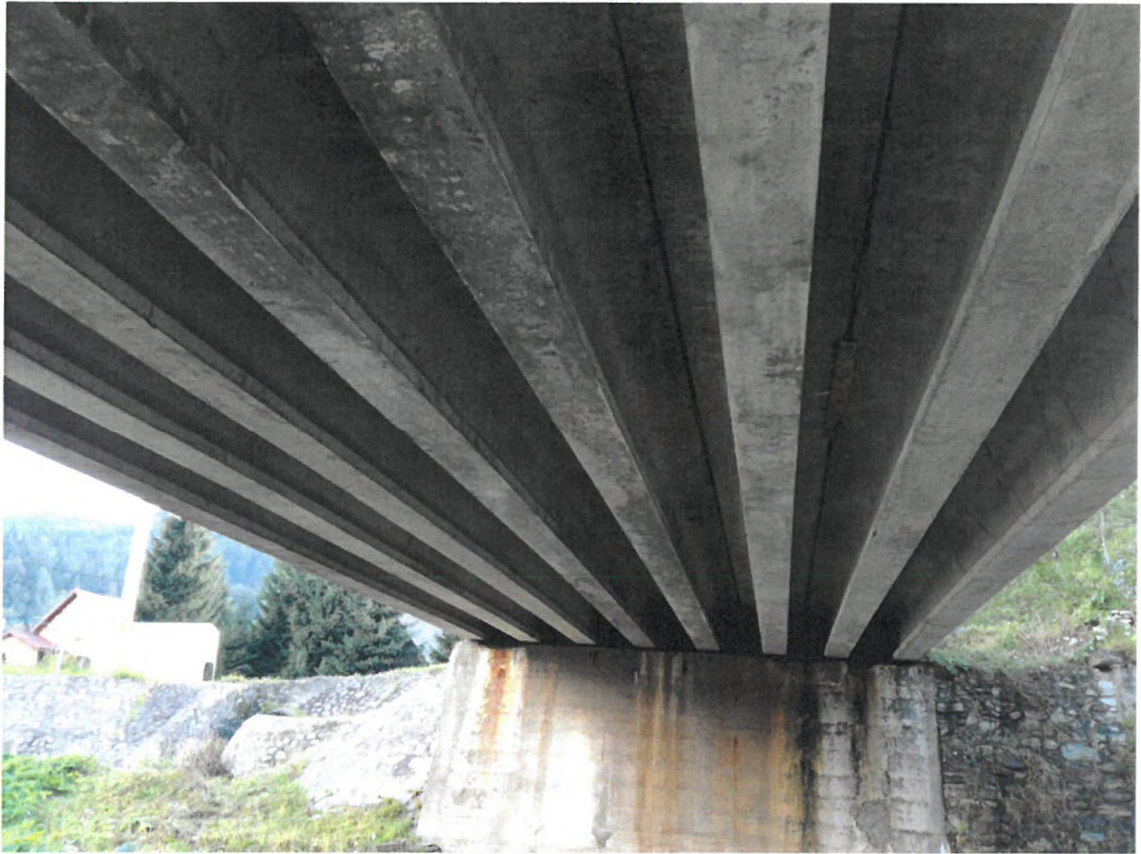
Foto nr. 3 – Defecte de suprafață ale feței văzute (culoare neuniformă, pete negre, impurități, pete de rugină, aspect prăfuit, imperfecțiuni geometrice, aspect macroporos, agregate la suprafață).
