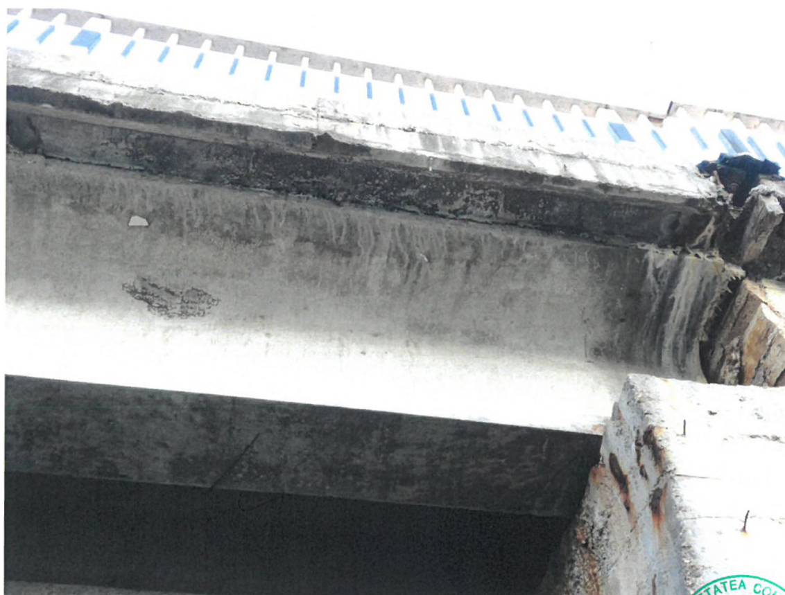
Foto nr. 1 - Armături fără strat de acoperire
